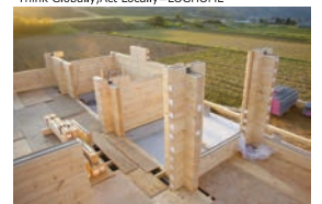
15段積みで15~20mmのセトリング
