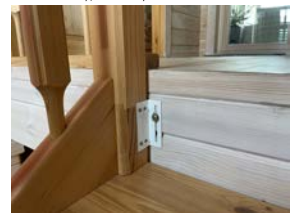
階段上部セトリング対策
